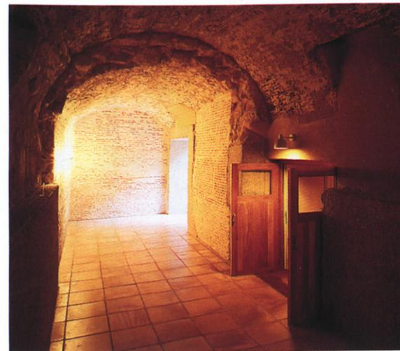
Los materiales empleados en el exterior han sido granito en los zócalos y arenisca de Villamayor en el resto de los muros, mientras en el interior los paramentos se han resuelto con hormigón tratado, revocos de cal y madera, y los pavimentos con barro, tarima de roble, granito y encachados.
